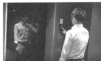
無人ホテル「ホテル・ザ・博多テラス」のエレベーター制御を可能にする「TOBIRA」。
